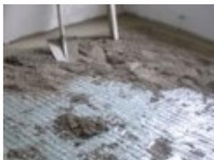
Trattasi della demolizione di pavimenti e rivestimenti di ogni genere, compreso il relativo sottofondo con l'ausilio di mazza e scalpello o martello demolitore elettrico e accatastamento del materiale di risulta nell'ambito del cantiere.
