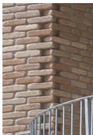
L'attività consiste nella realizzazione di murature in Blocchi di laterizio, che in base alla destinazione d'uso, possono essere suddivise in portanti e di tamponamento. In funzione delle modalità esecutive, inoltre, le murature faccia a vista possono essere ulteriormente distinte in diversi tipi:
