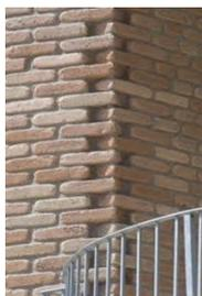
L'attività consiste nella realizzazione di murature in Blocchi di laterizio, che in base alla destinazione d'uso, possono essere suddivise in portanti e di tamponamento. In funzione delle modalità esecutive, inoltre, le murature faccia a vista possono essere ulteriormente distinte in diversi tipi:
